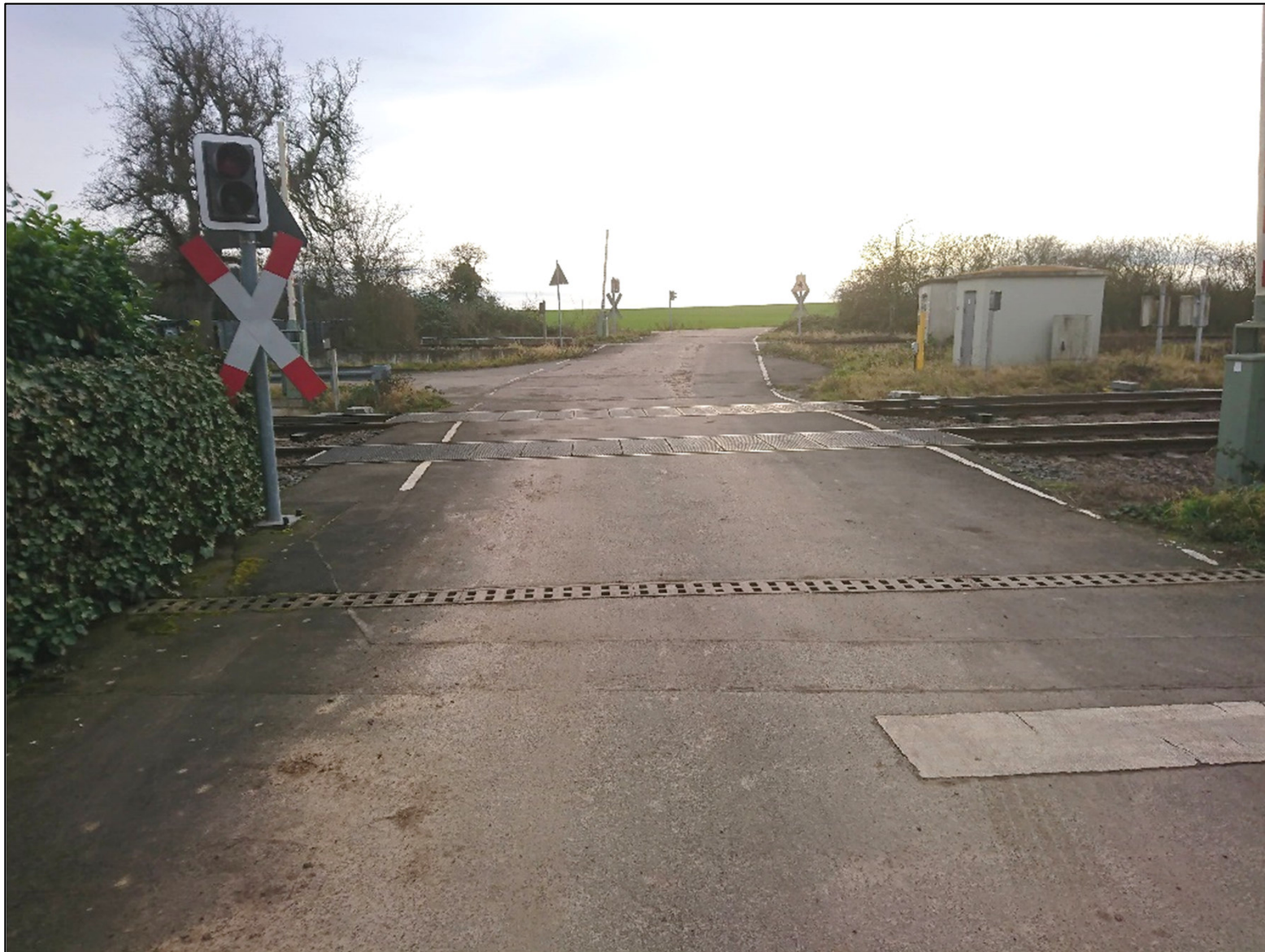
Bahnübergang Wasserturmstraße –Reinigung der Querrinnen
