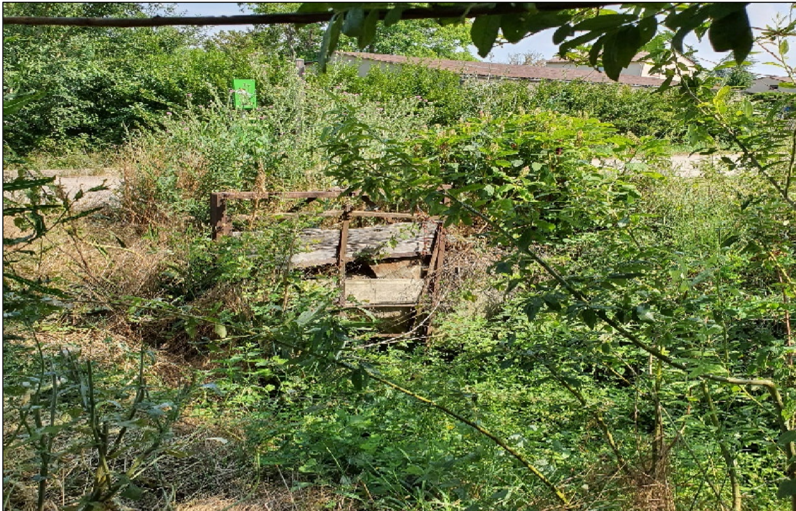
Graben des Grailsbaches – alte Schleuse (nach der Ortsbegehung bereits entfernt)
