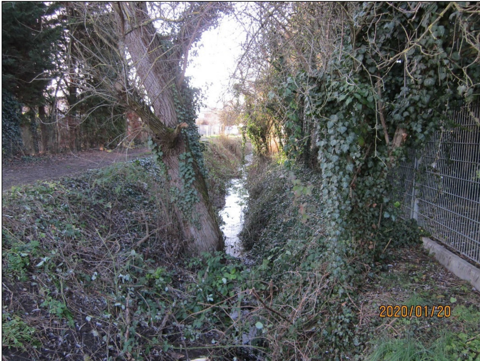
Graben des Grailsbaches nach der Ortslage, westlich der K37
