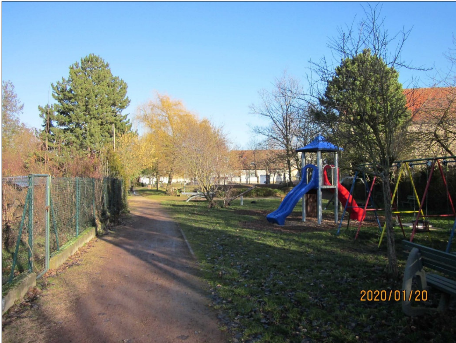
Spielplatz am Woog – Verrohrung Grailsbach
