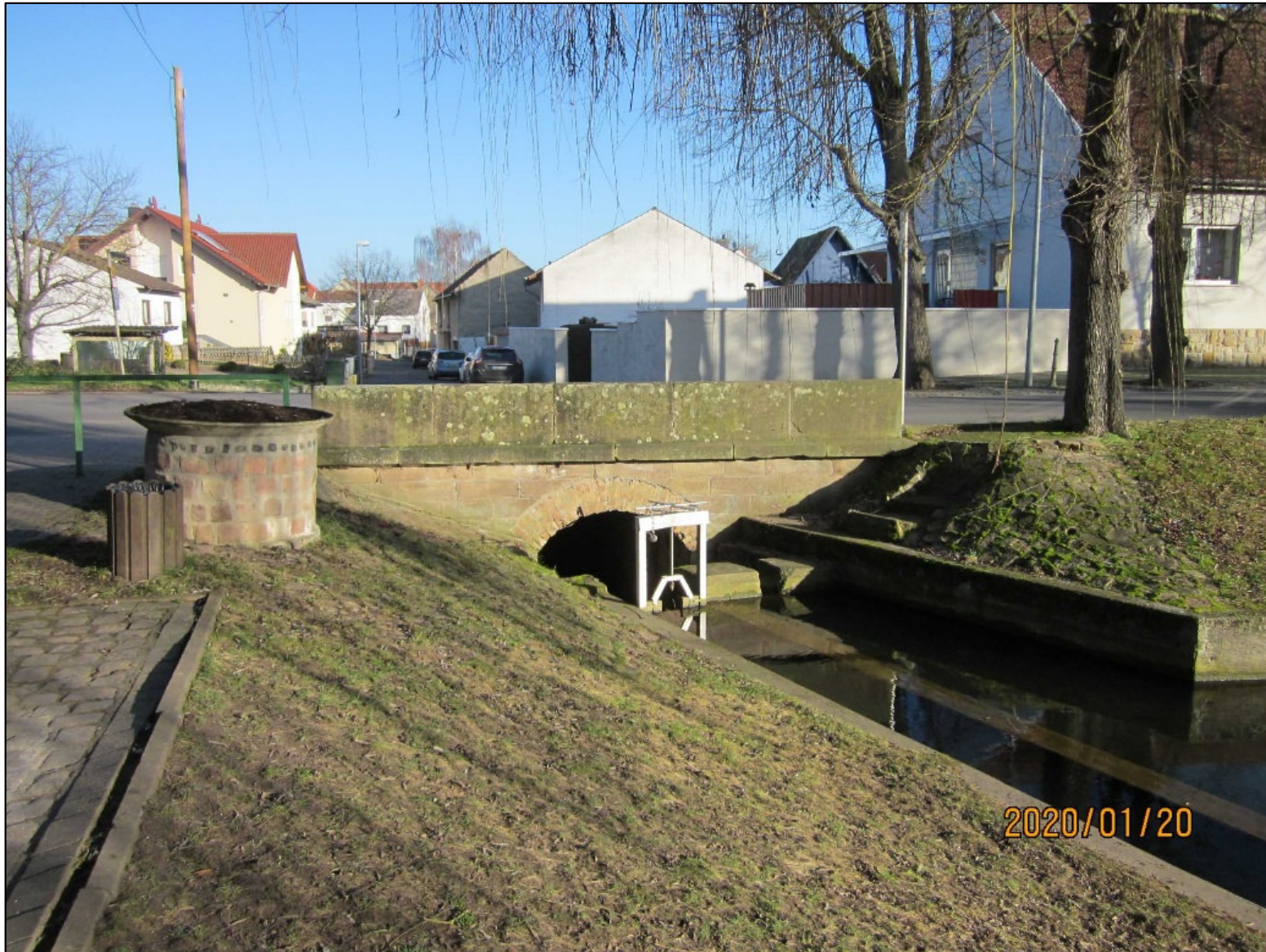
Grailsbach und Woog – Beginn Verrohrung Wooggasse/Borngasse
