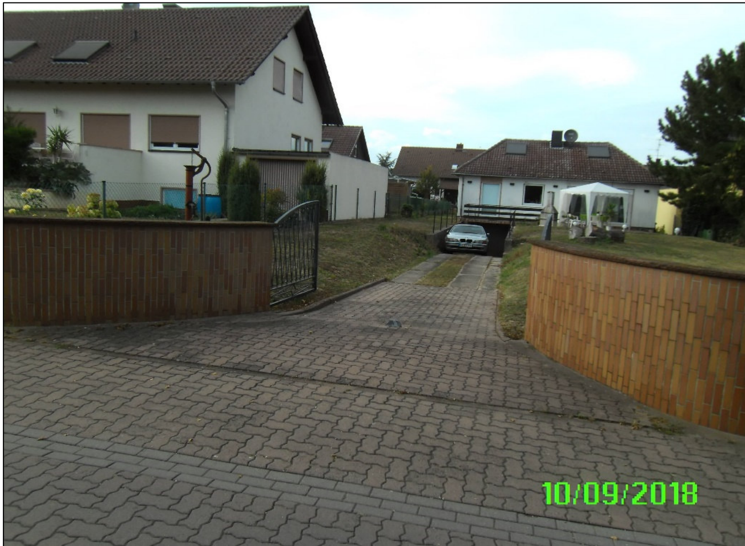
Weinbergstraße – Einfahrt in Tiefgarage ohne Schutz
