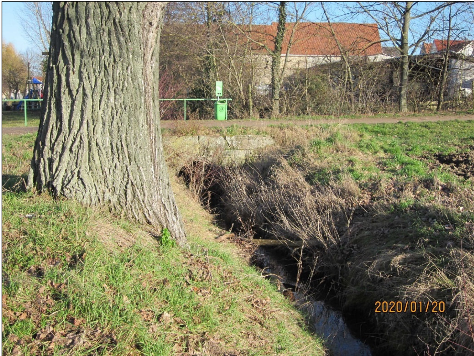
Grailsbach vor der Ortslage – Beginn Verrohrung
