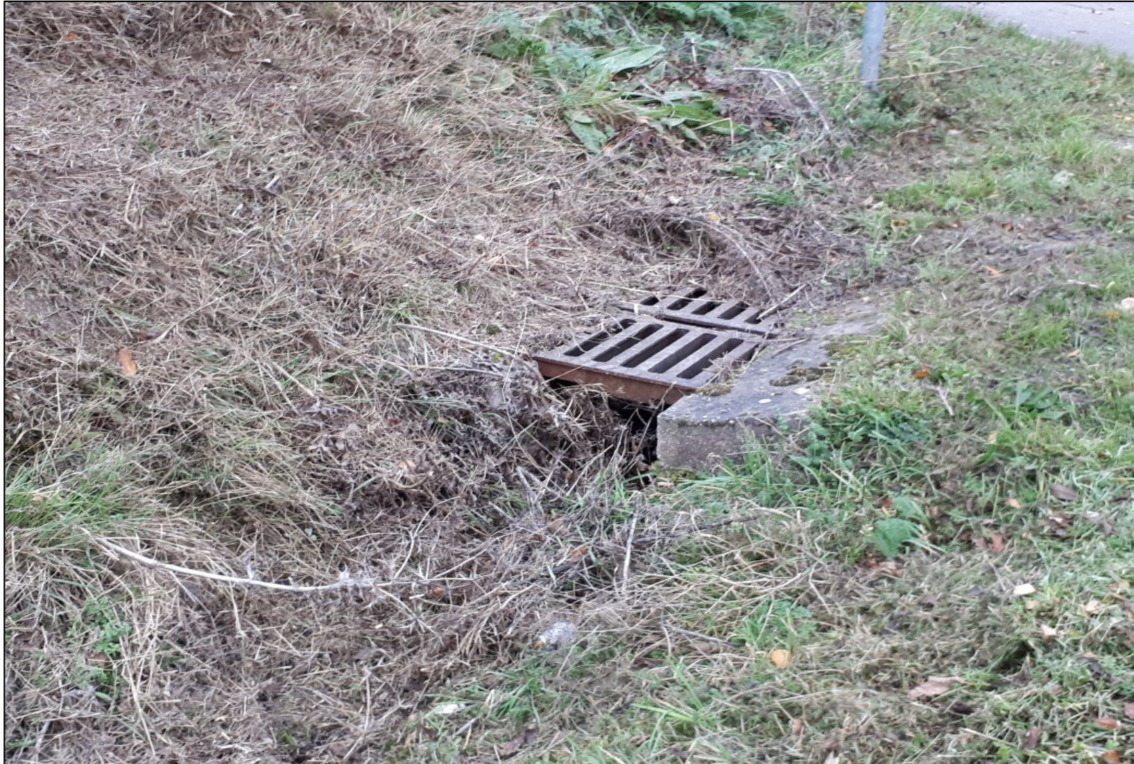
Hauptstraße – Ortsausgang Richtung Zell, Einlauf
