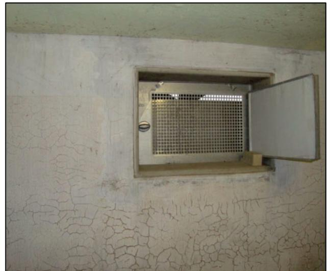
Abb. 37: Nachträgliche Einbauten von Türen und Kellerfenstern zum Schutz vor eindringendem Wasser (ibh)
