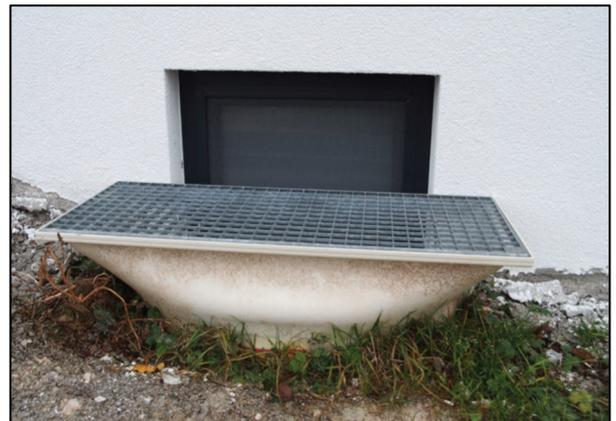
Abb. 35: Kellerfenster ohne Überflutungsschutz (links); Kellerfenster mit erhöhtem Lichtschacht (rechts) (LUBW)
