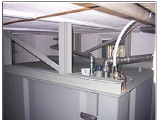
Abb. 38: Absicherung der Heizöltanks gegen das Aufschwimmen bei Starkregen (ibh)
