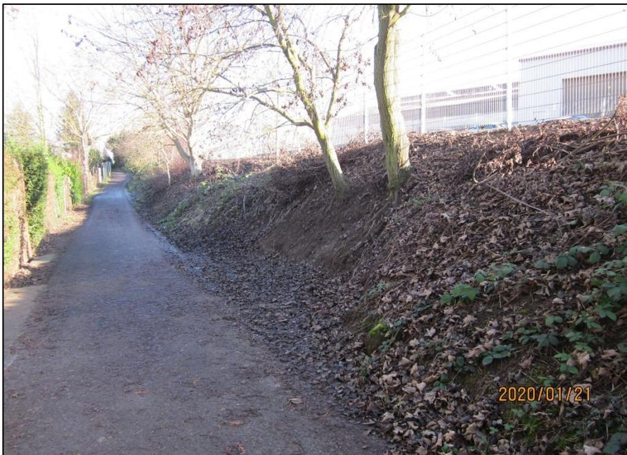
Abb. 9: Wirtschaftsweg - Erosion an der Böschung mit Freilegung von Wurzeln
