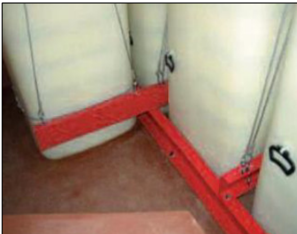
Abb. 40: Absicherung der Heizöl- und Gefahrstofftanks gegen das Aufschwimmen bei Starkregen (ibh)
