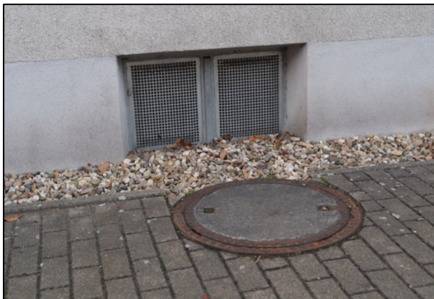
Abb. 37: Kellerfenster ohne Überflutungsschutz (links); Kellerfenster mit erhöhtem Lichtschacht (rechts) (LUBW)
