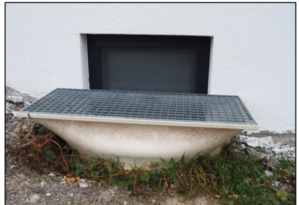
Abb. 37: Kellerfenster ohne Überflutungsschutz (links); Kellerfenster mit erhöhtem Lichtschacht (rechts) (LUBW)
