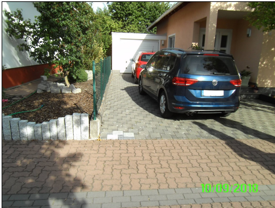
Abb. 24: Silvanerstraße – Garageneinfahrt, ebenerdig und ohne jeglichen Schutz
