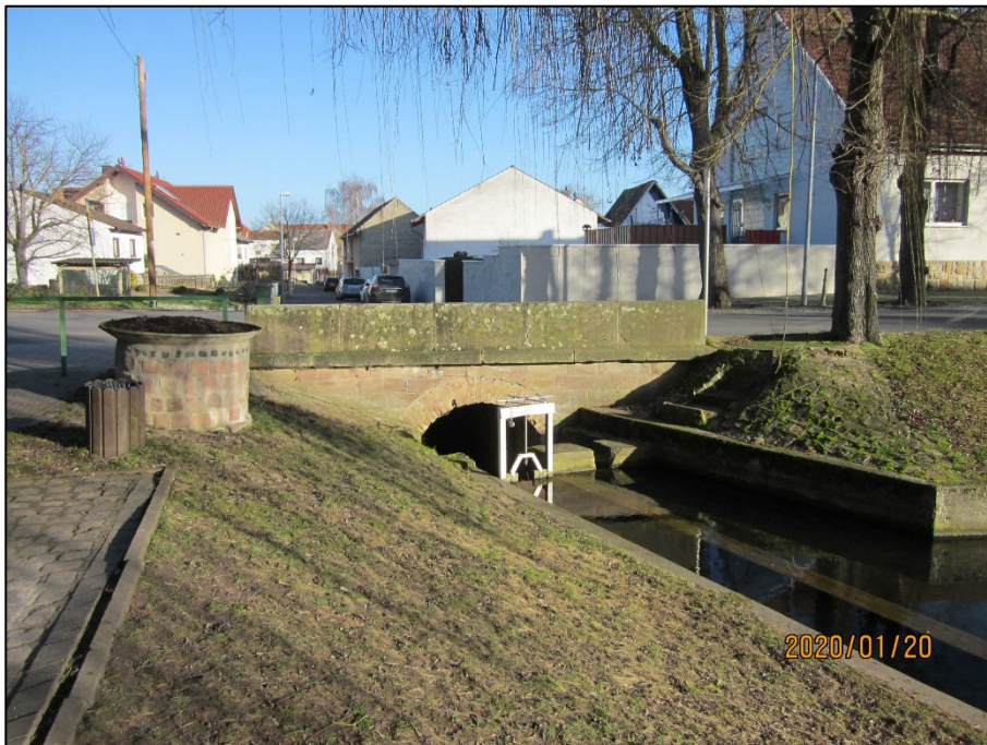
Abb. 7: Grailsbach und Woog – Beginn Verrohrung Wooggasse/Borngasse
