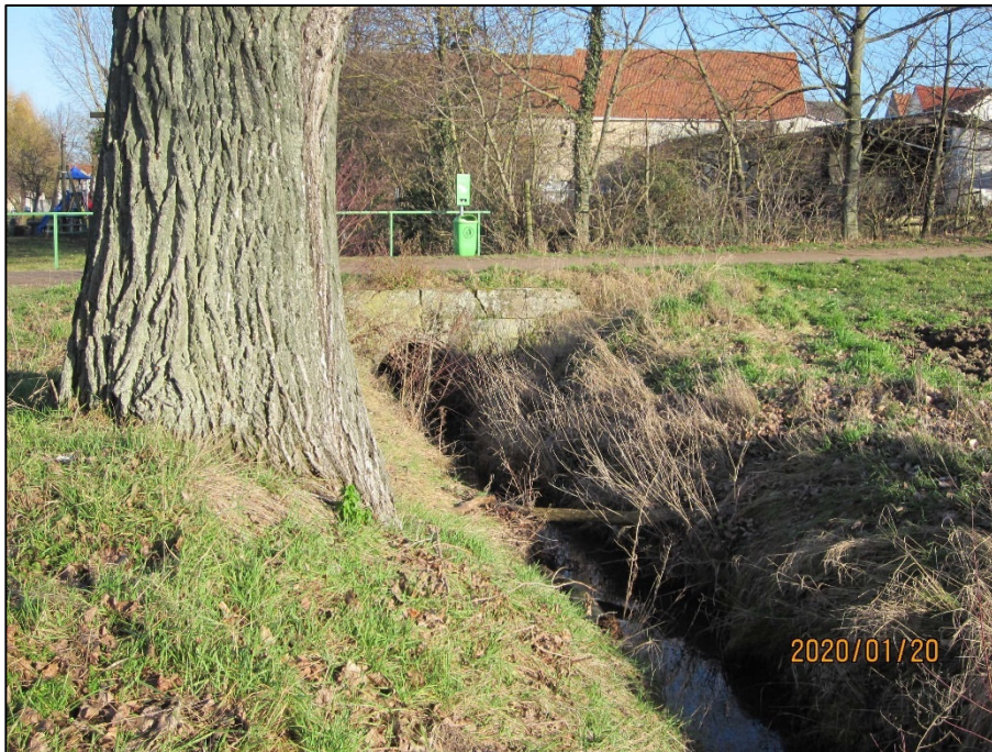
Abb. 5: Grailsbach vor der Ortslage – Beginn Verrohrung
