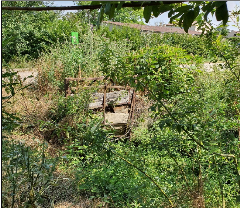
Abb. 16: Graben des Grailsbaches – alte Schleuse (nach der Ortsbegehung bereits entfernt)
