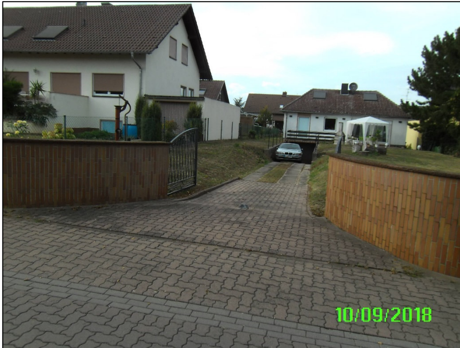
Abb. 26: Weinbergstraße – Einfahrt in Tiefgarage ohne Schutz
