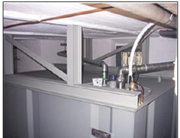
Abb. 40: Absicherung der Heizöl- und Gefahrstofftanks gegen das Aufschwimmen bei Starkregen (ibh)
