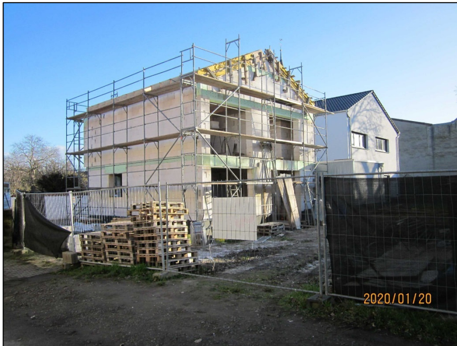
Abb. 12: Bachgasse – Neubau mit ebenerdigen Festern
