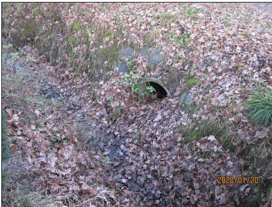
Abb. 12: Zugesetzter Graben und Verrohrung durch Laubfall
