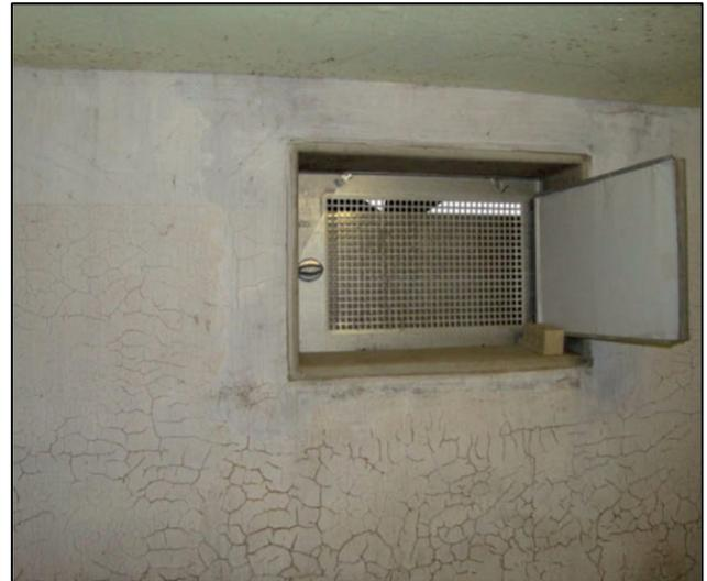
Abb. 40: Nachträgliche Einbauten von Türen und Kellerfenstern zum Schutz vor eindringendem Wasser (ibh)
