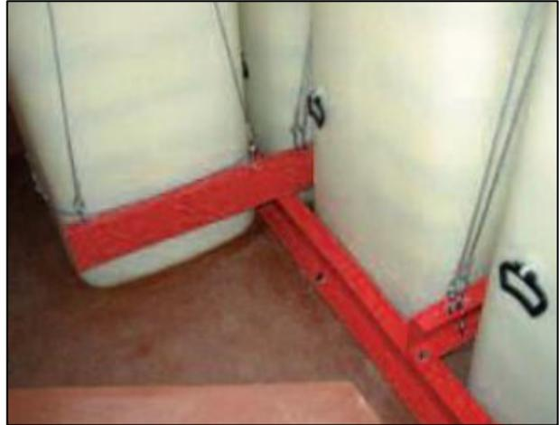
Abb. 41: Absicherung der Heizöltanks gegen das Aufschwimmen bei Starkregen (ibh)
