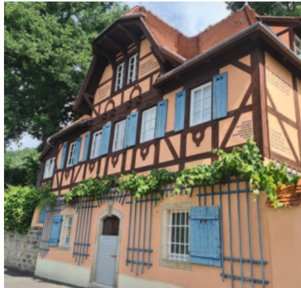
Denkmalschutz mit Hochwasserschutz
