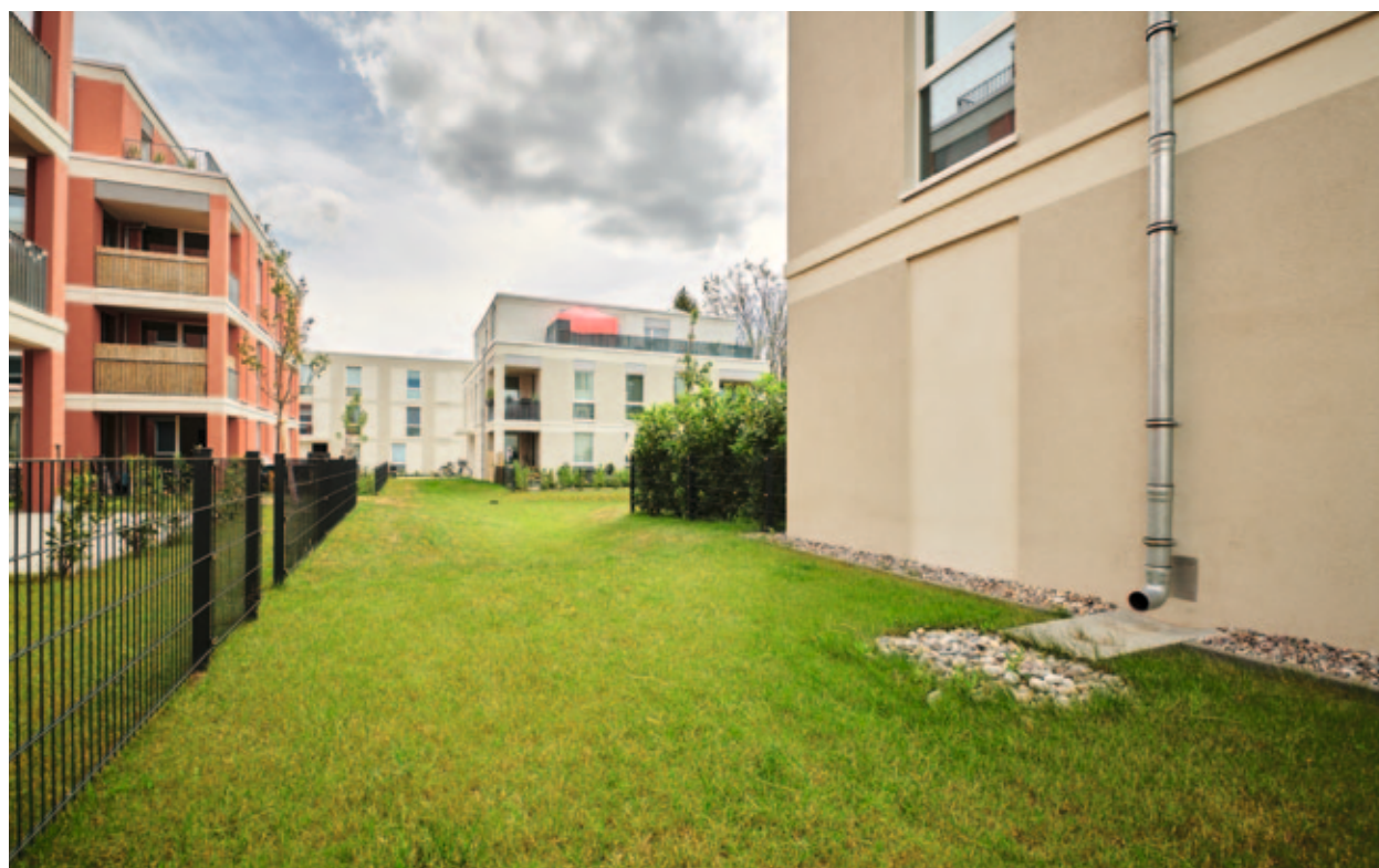
Dezentrale Rückhaltung von Niederschlagswasser
