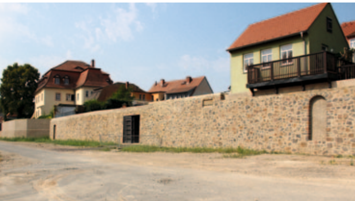
Integrierter Hochwasserschutz in der historischen Stadtmauer ...
