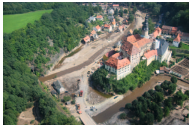
Hochwasserschäden 2002 in Weesenstein an der Müglitz ...
