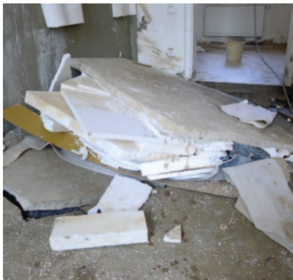
Aufgeschwommene Fußbodenkonstruktion
