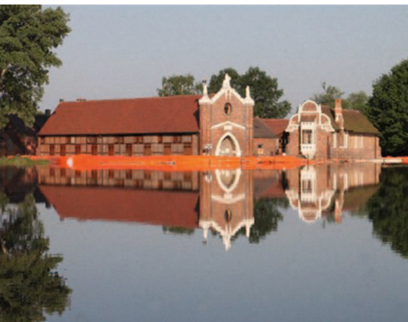
Objektschutz mit mobilem wassergefülltem Schlauchsystem
