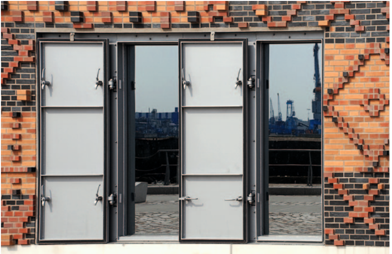
Integrierte Flutschutztüren
