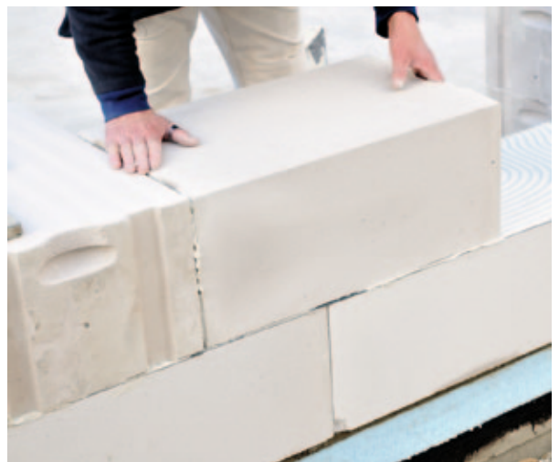
Mauerwerk aus Porenbeton-Plansteinen
