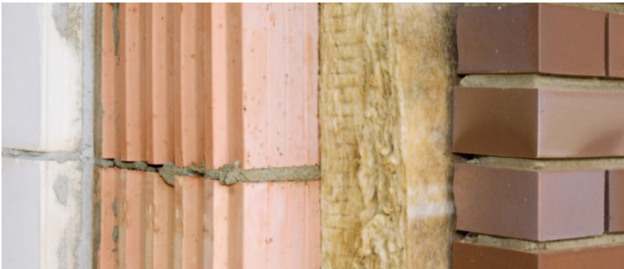
Bei mehrschaligen Außenwandkonstruktionen ist die durchfeuchtete Dämmschicht nur sehr schwer zugänglich.
