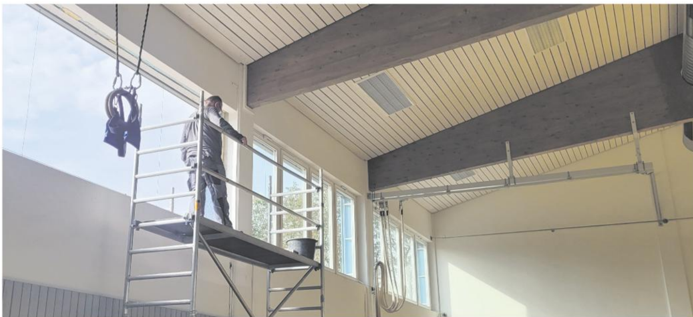
Mitarbeiter der Tischlerei Christ aus Waldlaubersheim erneuern die Fenster in der Offsteiner Engelsberghalle.
