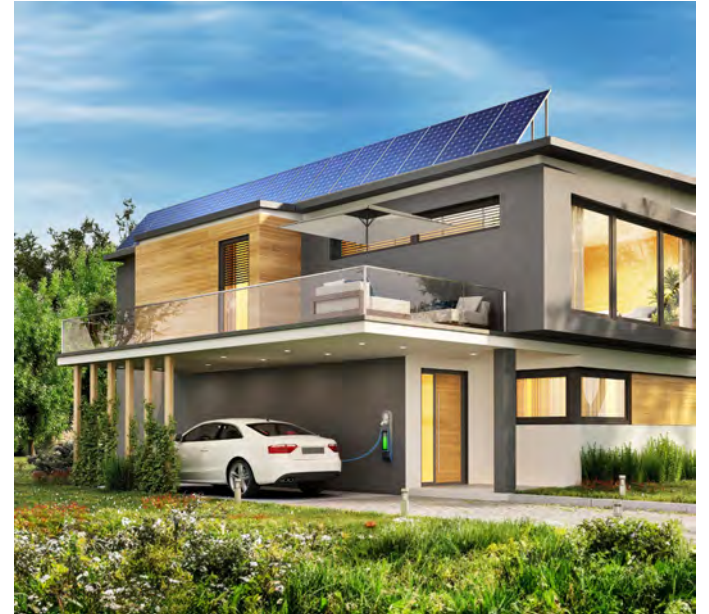
Zertifizierte Sicherheitstechnik sorgt dafür, dass Gefahren im Haus frühzeitig erkannt werden und die Eigentümer im Ernstfall schnell reagieren können.
