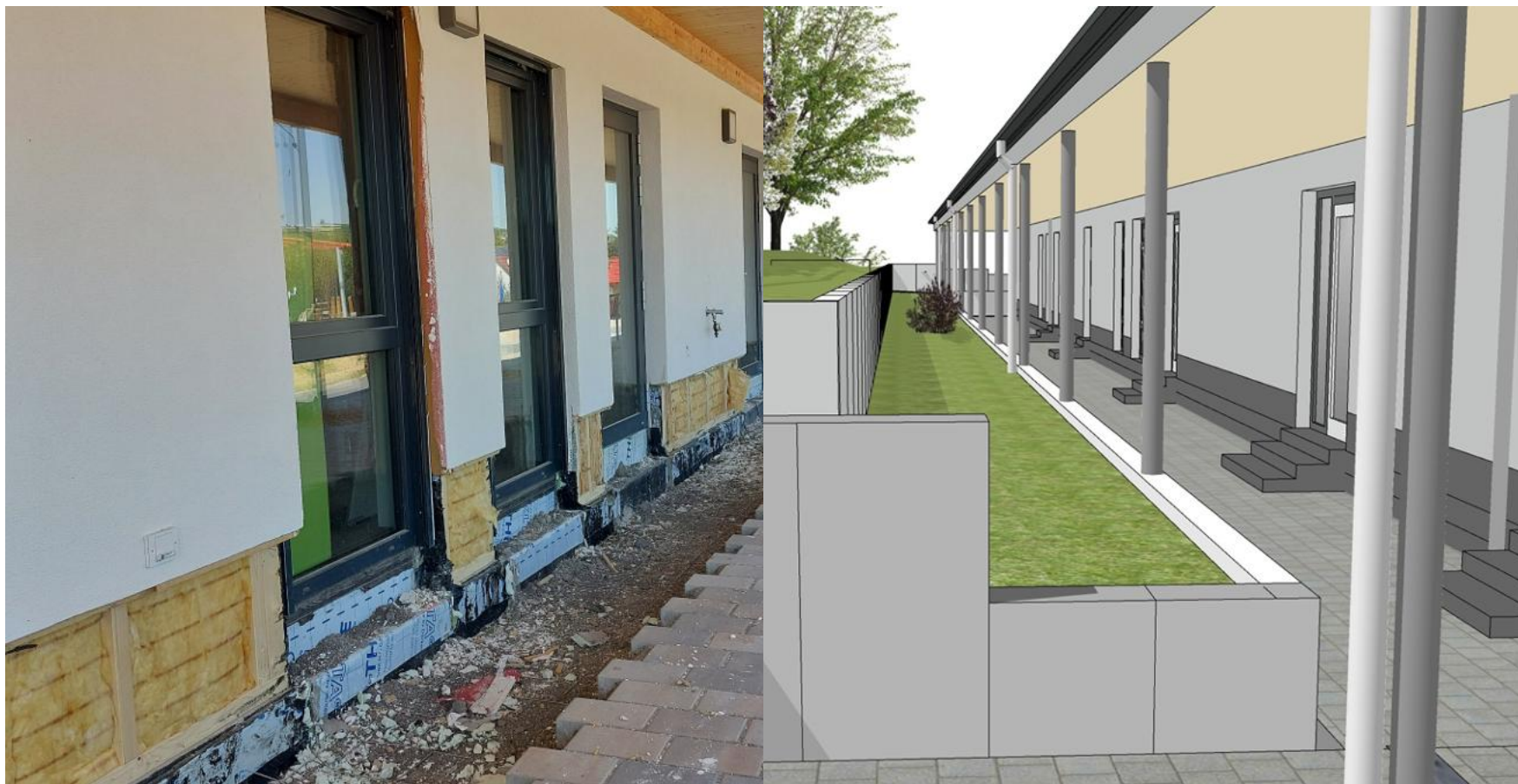
Aktuell wurden an der Nordseite Rückbauarbeiten vorgenommen: Rückbau des Sockels, teilweise Entfernung der Dämmung, OSB-Platten, Abdichtungen, Pflaster
