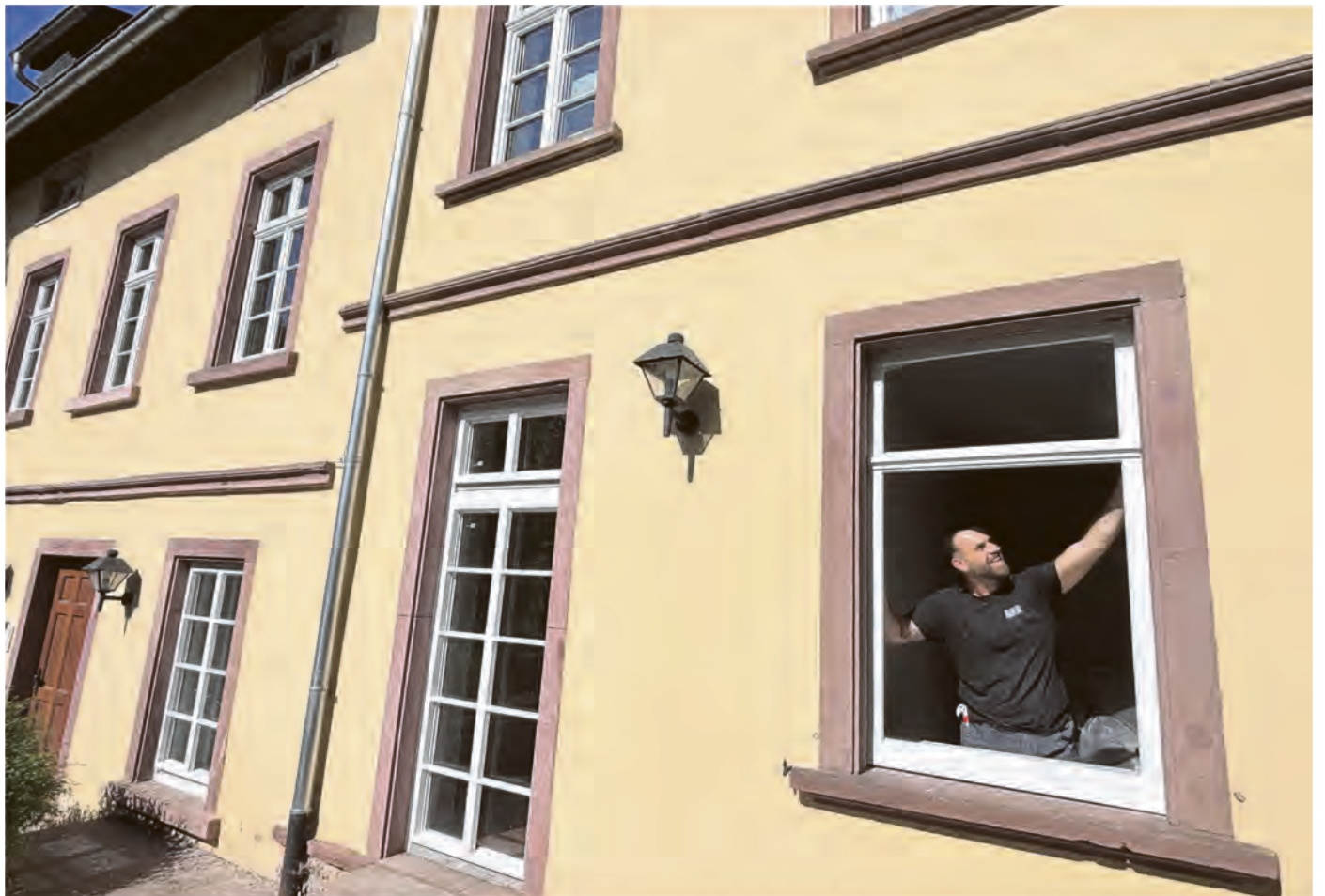
Rilind Hasaj und sein Team von RSH-Montagebau aus Niederzissen tauschen im laufenden Verwaltungsbetrieb die Fenster und Außentüren der „Anhäuser Mühle“ aus.
