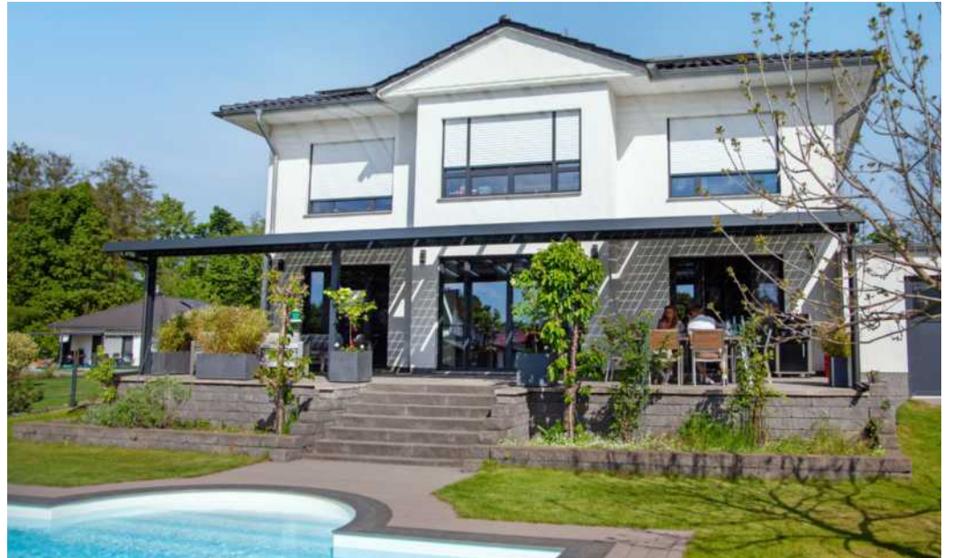
Mehrfacher Nutzen: Ein Solarterrasendach wertet den Bereich unter freiem Himmel optisch auf und liefert Ökostrom frei Haus. Foto: DJD/www.premium-solarglas.com
