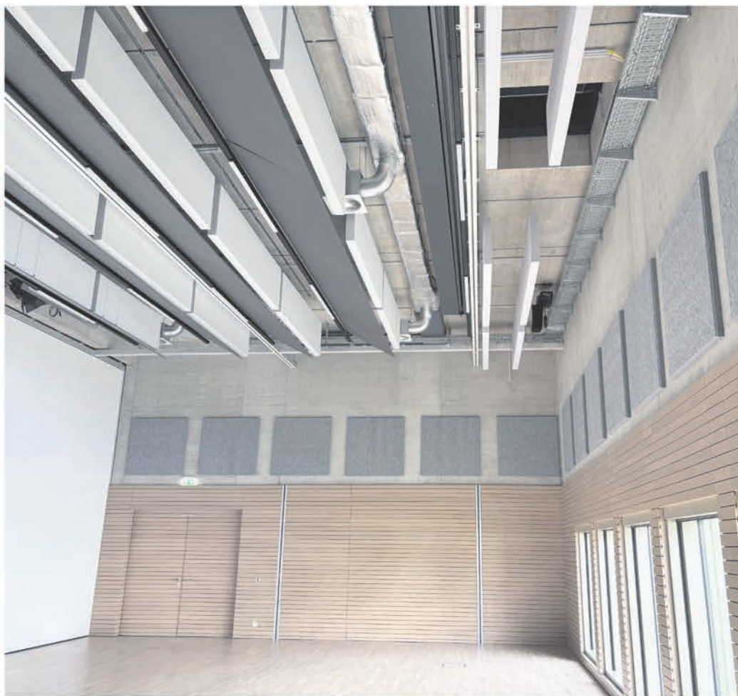
Schall-Absorber an Wänden und Decke sorgen zukünftig für eine angenehmere Raumakustik im Bühnenbereich der Rhein Hessenhalle, wenn dieser zu Trainingszwecken genutzt wird.
