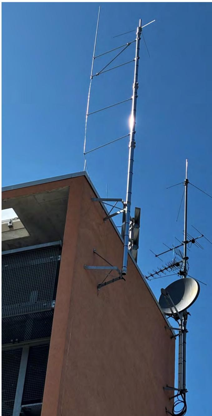
*Der neue Digitale Alarmumsetzer (DAU) am Feuerwehrhaus Monsheim ermöglicht über eine zusätzliche Funkantenne insbesondere die netzunabhängige gezielte Alarmierung von Einsatzkräften innerhalb der VG und des Landkreises Alzey-Worms.*
