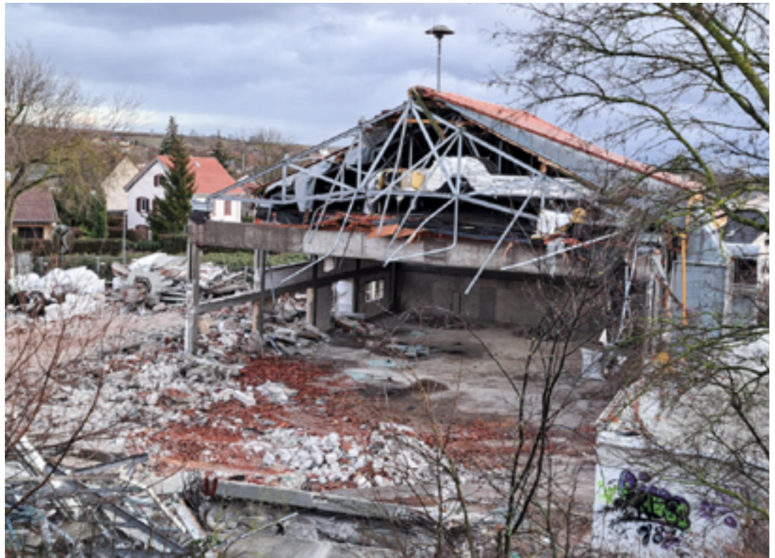
Die alte Schulsporthalle in Monsheim wurde in den letzten Tagen durch ein Fachunternehmen abgerissen.
