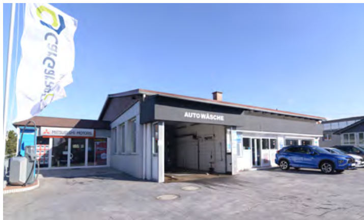
Nach einer halbjährigen Umbaupause ist die Waschanlage wieder in Betrieb.
