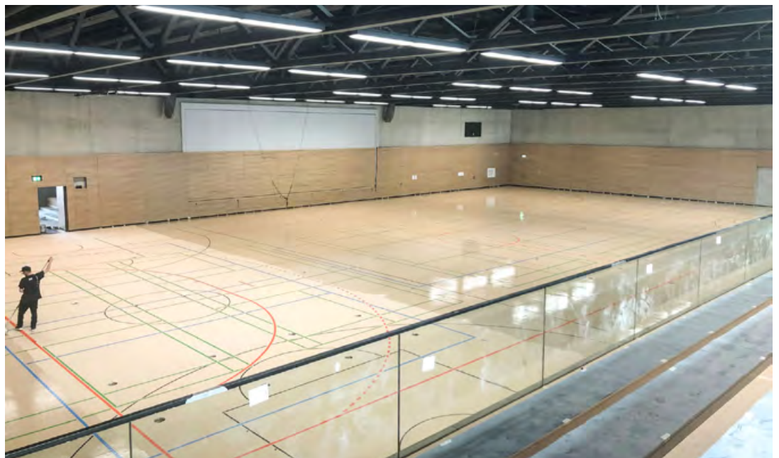
Die Sportflächen in der Rheinessenhalle sind bereits markiert und der Boden wird abschließend versiegelt. Bis zur Einweihung am 6. Mai 2023 soll endlich alles fertig sein.
