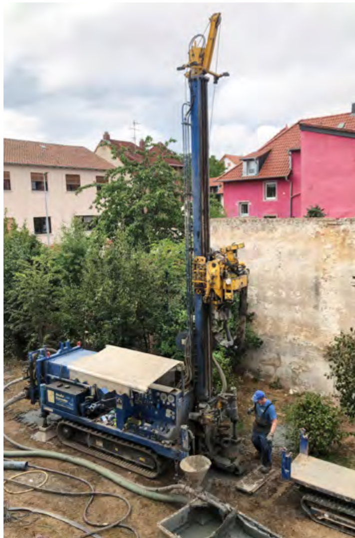
Um die Erdwärme nutzen zu können, wurden westlich des Schulgebäudes fünf Bohrungen bis zu einer Tiefe von 100 m niedergebracht.
