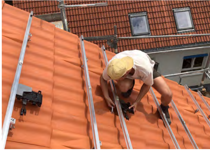
Dezentrale Lösung: Jeder Mikrowechselrichter ist nur mit einem einzigen Photovoltaik-Modul verbunden. (Foto: djd/enphaseenergy.com/Zimmerei Schwarz/Solar Kollektiv)
