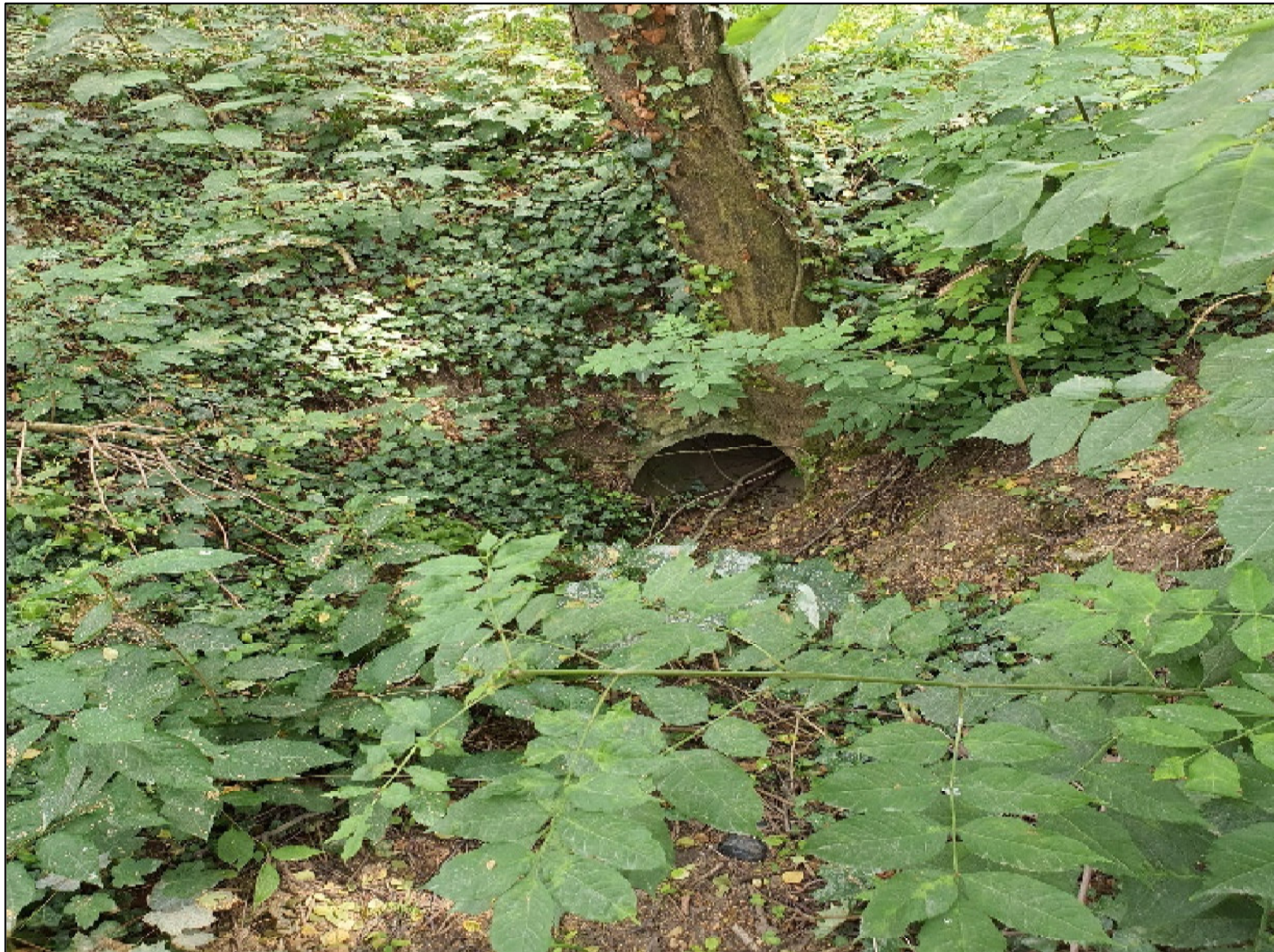
Baum der direkt auf dem Einlauf wächst
