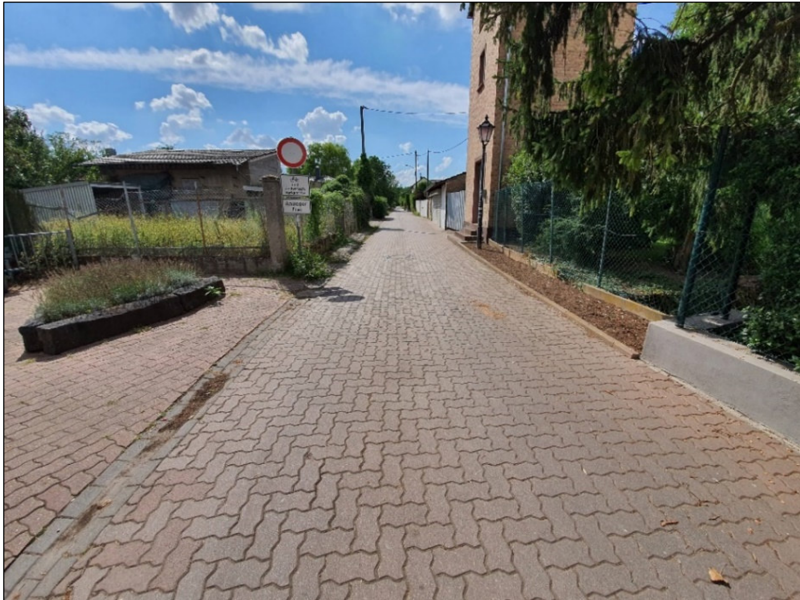
Wirtschaftsweg – von Gerbereistraße Blickrichtung Westen
