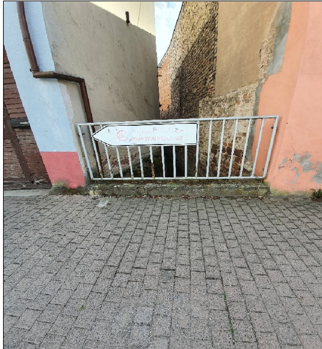
Auslauf Reisbach -Kreuzung Neuoffsteiner Straße
