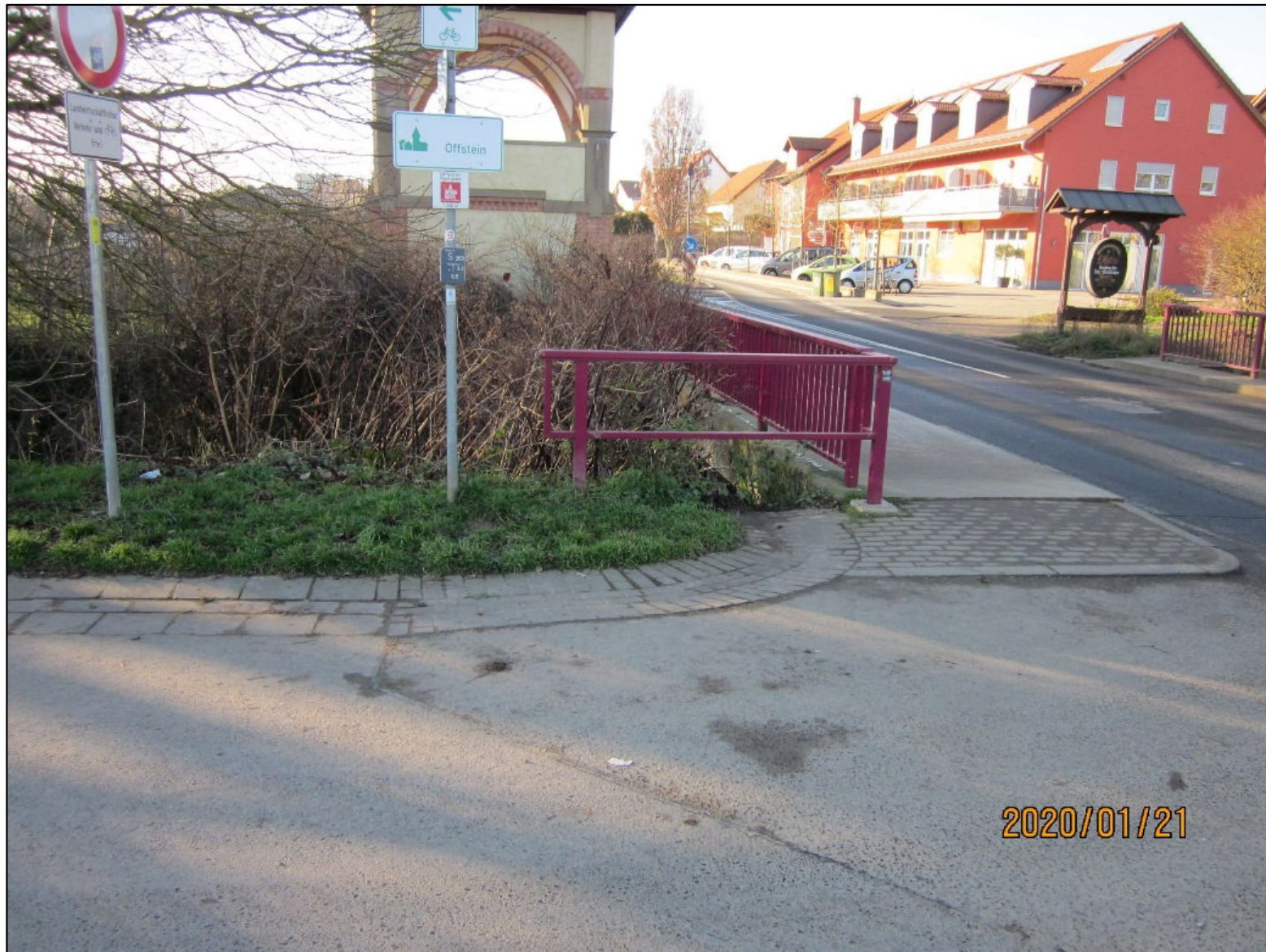
Brücke Wormser Straße – 90° Führung der Rinne
