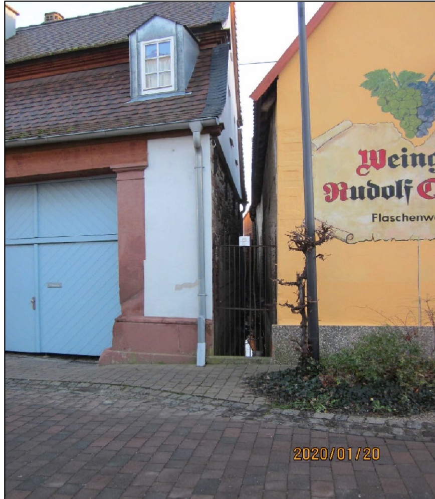
Rail zum Ortsgraben
