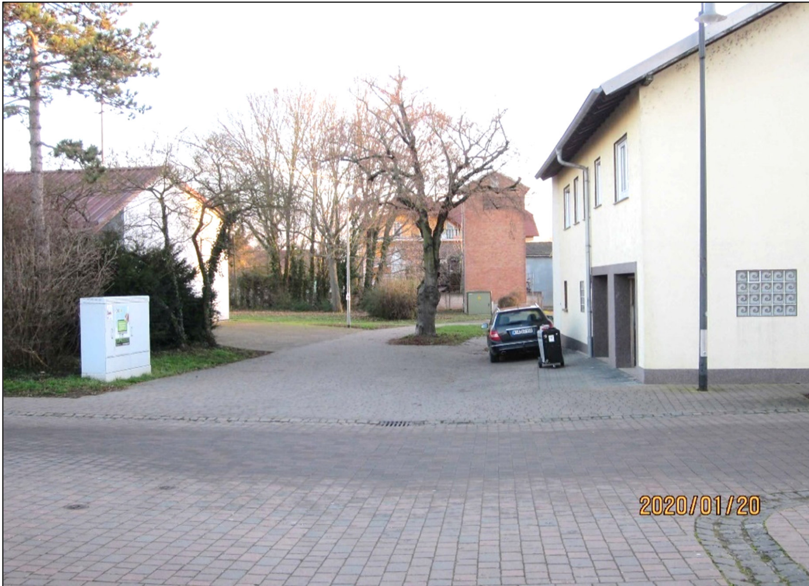
Hauptstraße mit Blick in Richtung Graben
