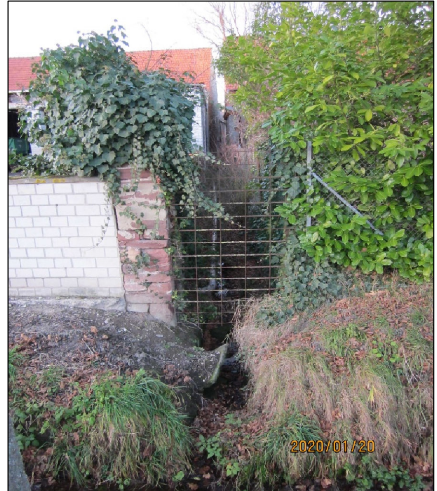
Rail Ausmündung Ortsgraben
