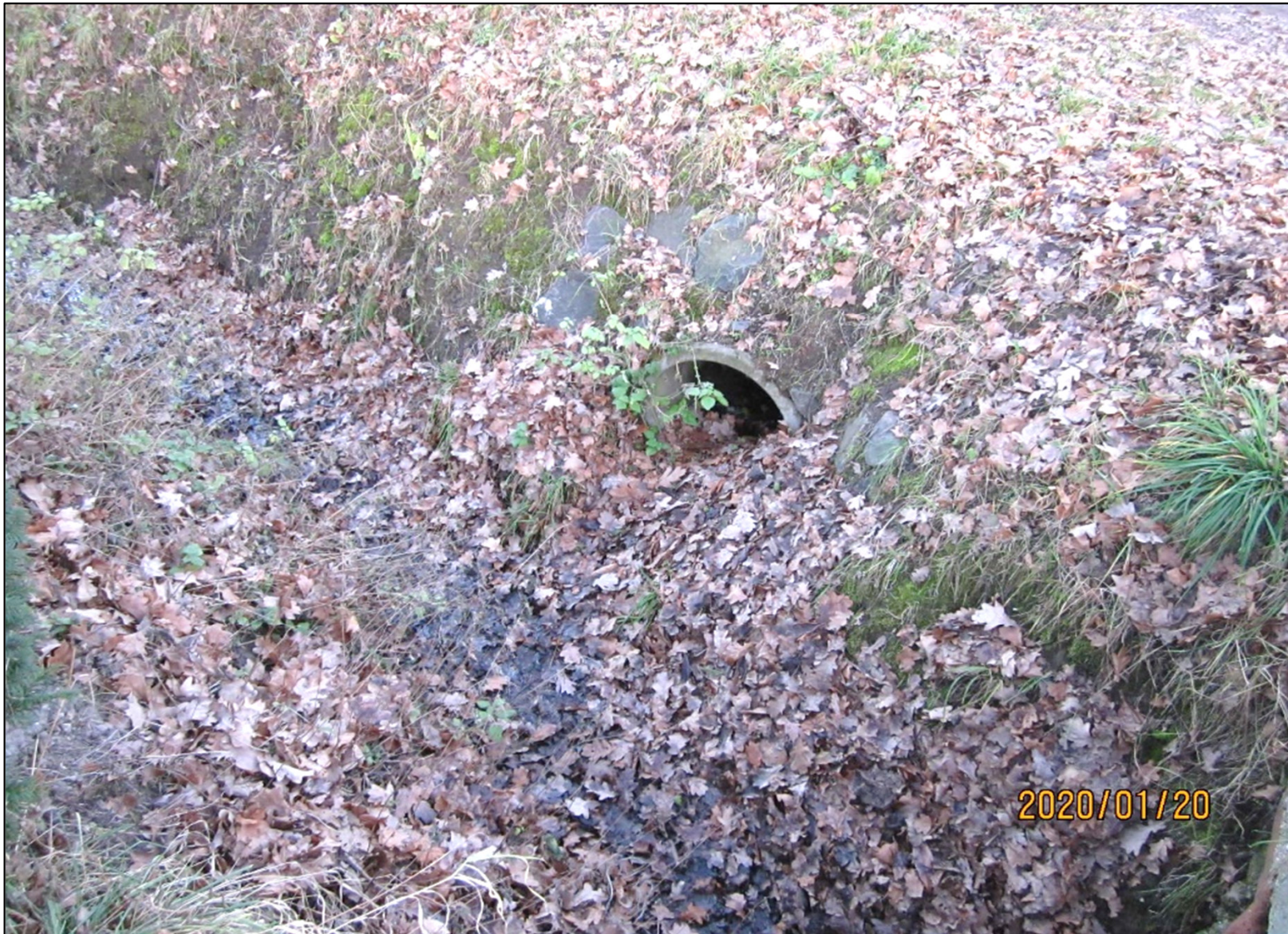
Ortsgraben mit Zulauf Nbg. Ort
