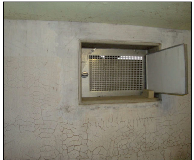
Abb. 45: Nachträgliche Einbauten von Türen und Kellerfenstern zum Schutz vor eindringendem Wasser (ibh)
