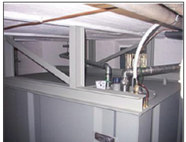
Abb. 46: Absicherung der Heizöltanks gegen das Aufschwimmen bei Starkregen (ibh)
