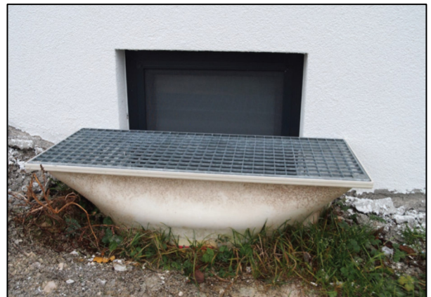
Abb.43: Kellerfenster ohne Überflutungsschutz (links); Kellerfenster mit erhöhtem Lichtschacht (rechts) (LUBW)
