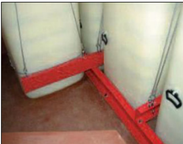
Abb. 46: Absicherung der Heizöltanks gegen das Aufschwimmen bei Starkregen (ibh)
