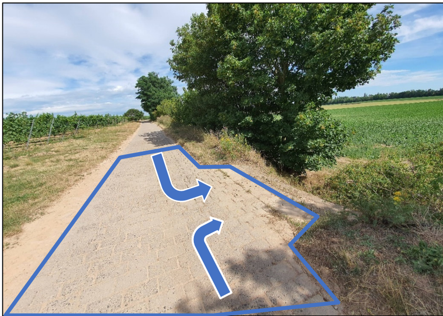
Abb. 20: Galgenweg – südlicher Rand und Graben
