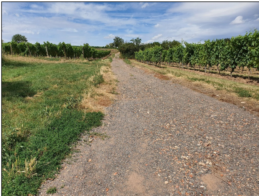
Abb. 16: Wirtschaftsweg vom Lochpfad Richtung Außengebiet
