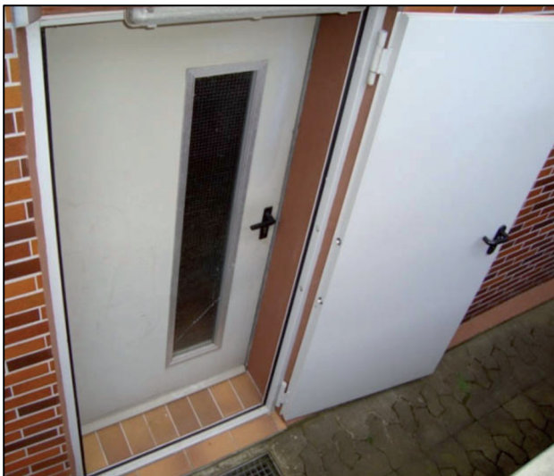
Abb. 45: Nachträgliche Einbauten von Türen und Kellerfenstern zum Schutz vor eindringendem Wasser (ibh)
