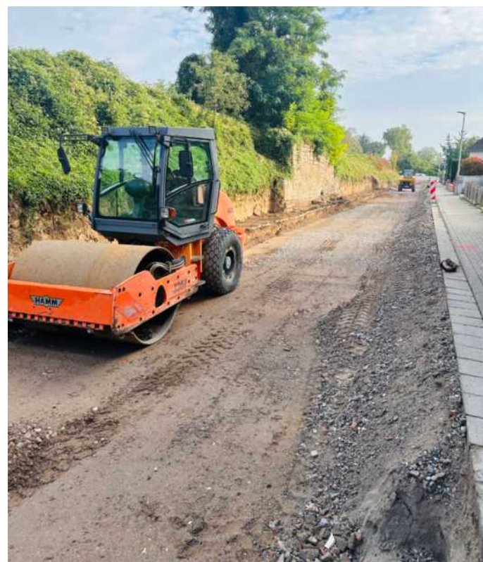
Die letzte Etappe hat begonnen: In der Bahnhofstraße laufen derzeit die Erdarbeiten für den dritten Bauabschnitt.
