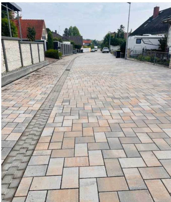
Fertiggestellt: Der zweite Bauabschnitt der Albert-Schweitzer-Straße mit dem neu angelegten Pflasterbelag. Fotos: Ortsgemeinde Flörsheim-Dalsheim
