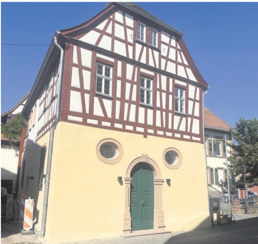
Die Fassade des historischen Rathauses wurde umfassend denkmalgerecht saniert. Die Restarbeiten an der Außenanlage werden bis zur Eröffnung abgeschlossen sein.
