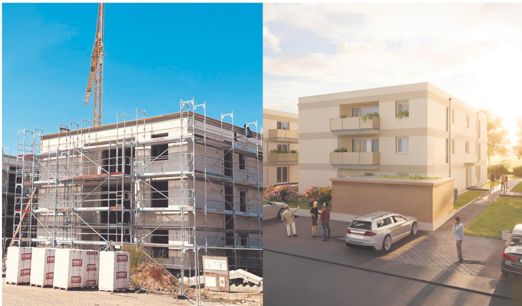
Die Gebäude an der Burgunderstraße im aktuellen Bauzustand und eine Visualisierung des möglichen Zustandes nach Fertigstellung Anfang 2027.
