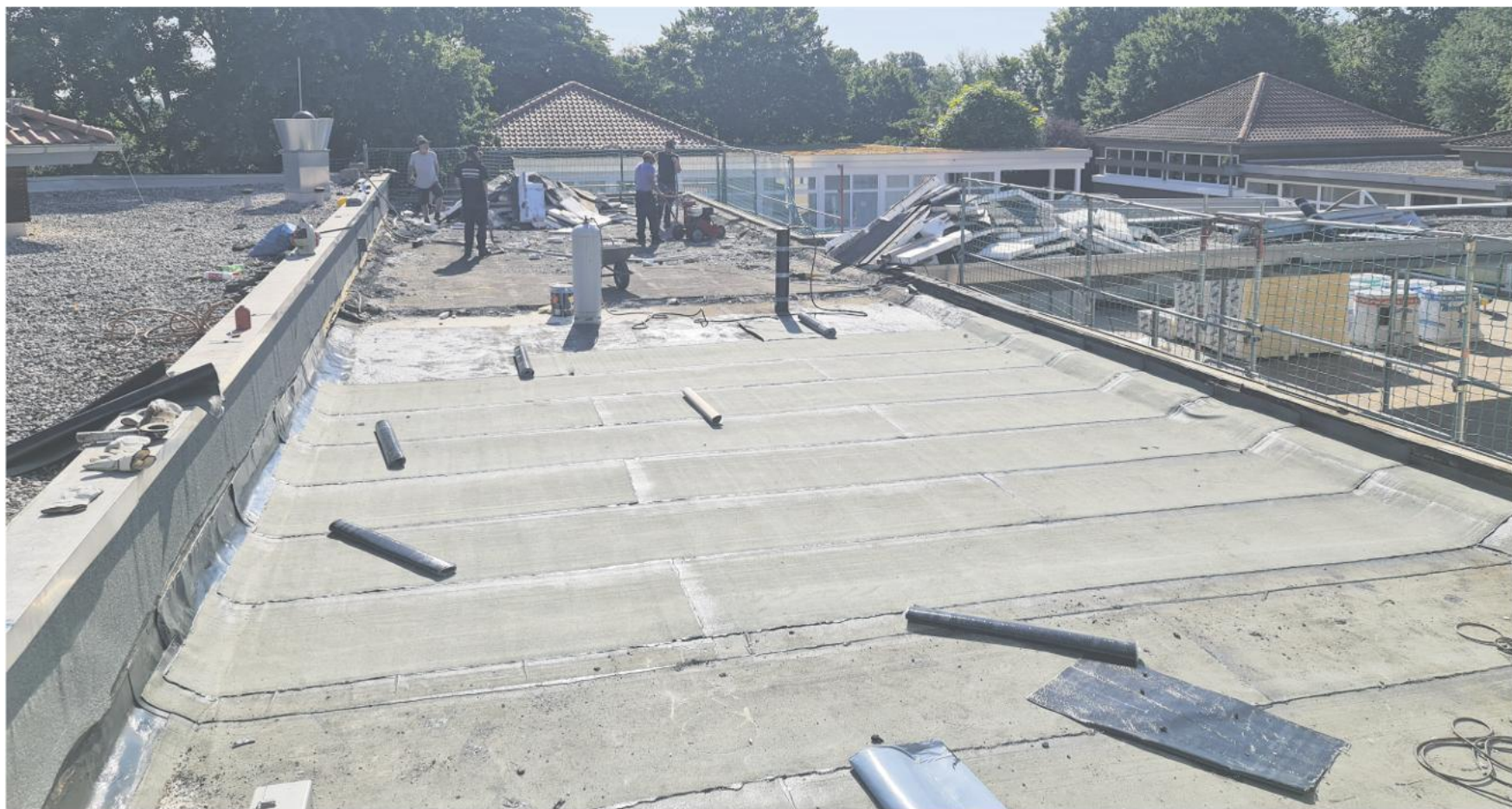
Die Flachdachbereiche der Grundschule Monsheim werden in den Sommerferien 2026 vollständig erneuert.
