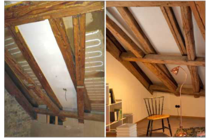
Mit Lehm-Klimaplatten als Flächenheizung und -kühlung lassen sich Dachgeschosse ganzjährig angenehm klimatisieren. Den Einbau können versierte Heimwerker sogar selbst vornehmen. Foto: DJD/naturbo
