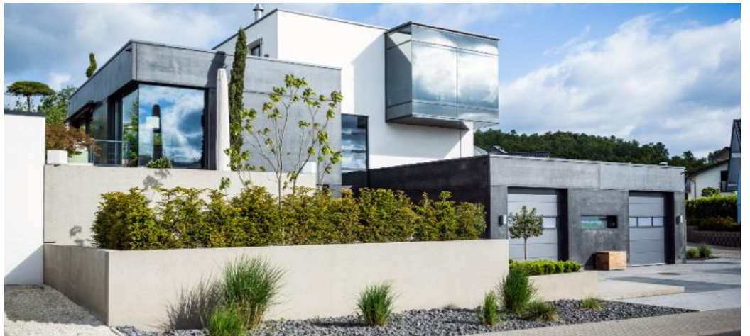
Bodenaufbau und Estrich ermöglichen im Zusammenspiel eine energiesparende Wärmeversorgung.
