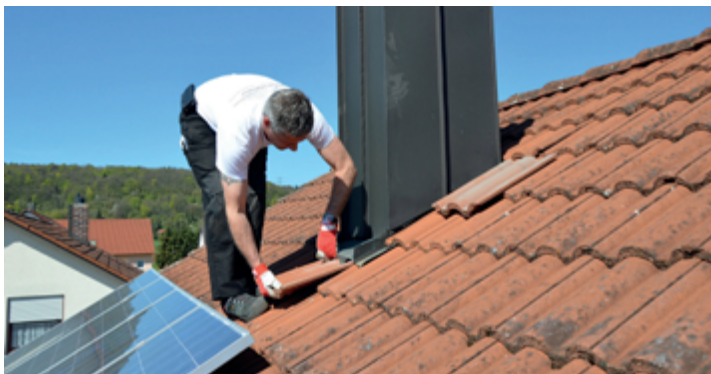
Anschlüsse an Dachdurchdringungen werden beim DachCheck begutachtet.
