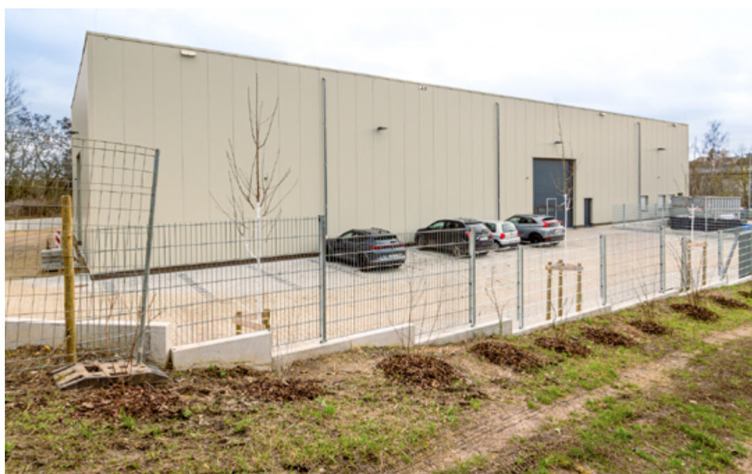
Die neue Bauhofhalle fügt sich mit einer dezenten Farbgebung gut in die Landschaft ein.
