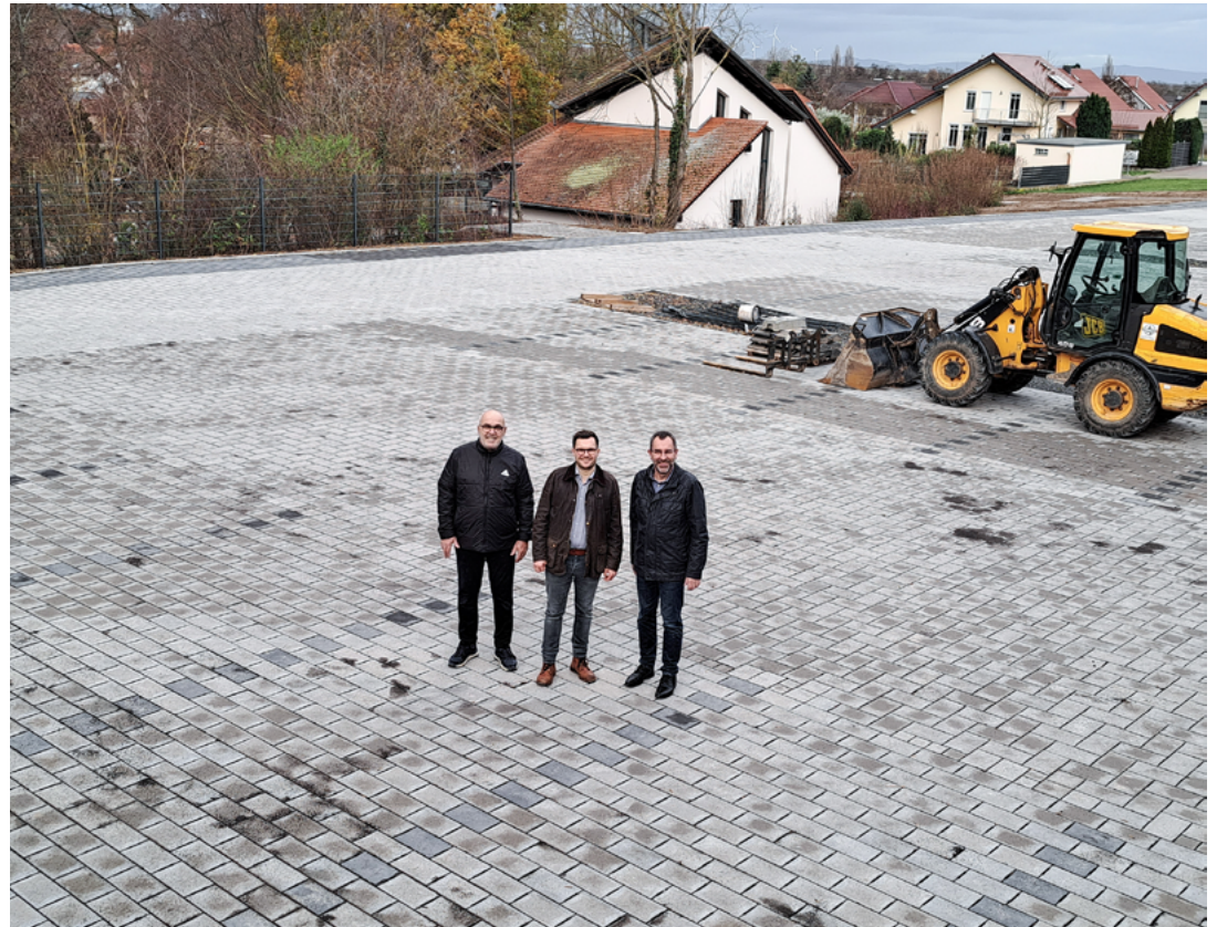
Bei der abschließenden Begehung der Friedhofserweiterung und des neuen Parkplatzes zeigen sich Bürgermeister Ralph Bothe, Bautechniker Ayhan Coban, welcher die Maßnahme geplant und betreut hat, sowie Ortsbürgermeister Kevin Zakostelny zufrieden mit dem Ergebnis.
