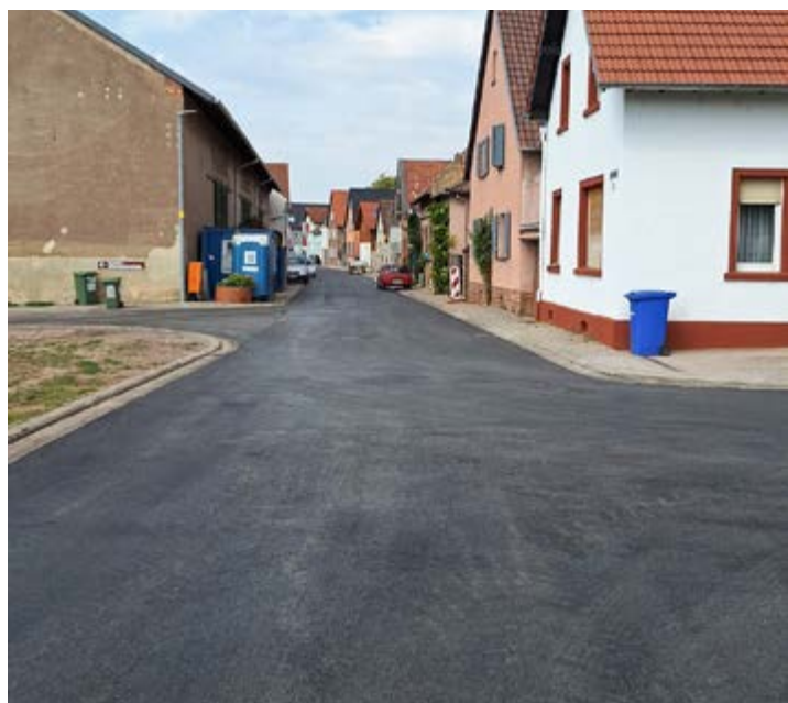
Die Fahrbahn der Kriegsheimer Hauptstraße wurde im Zuge der Baumaßnahme vollständig erneuert. (Foto: Ortsgemeinde Monsheim)
