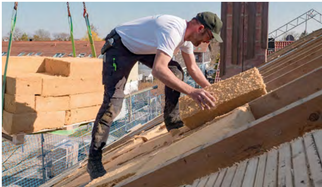
Bei der Dachsanierung von außen werden flexible Holzfaser-Dämmmatten zwischen die Sparren geklemmt.
