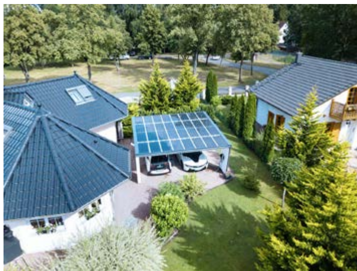
Das Carportdach mit Solarglas Modulen lässt sich ebenfalls zur nachhaltigen Stromgewinnung nutzen.
