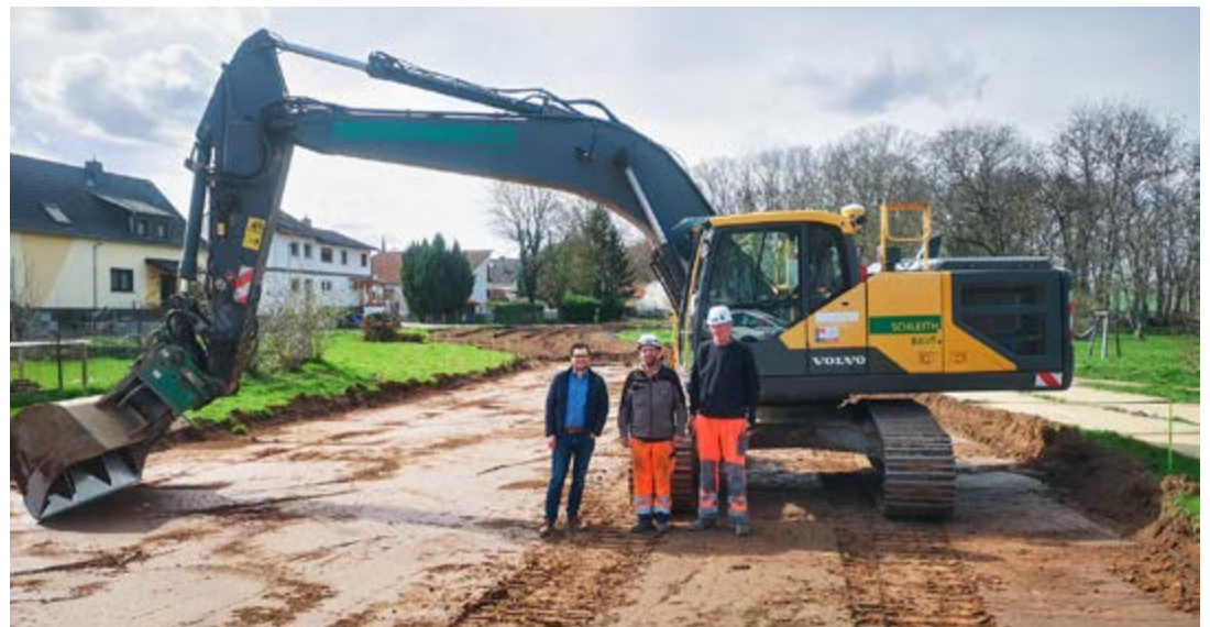
Ortsbürgermeister Kevin Zakostelny (li.) und Polier Giuliano Salvatore Piras (Mitte) auf der Fläche des künftigen Erdwalls am Mehrgenerationenplatz. (Bild: Ortsgemeinde Monsheim)
