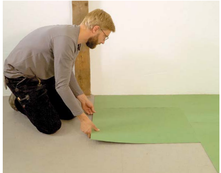
Bauherren legen Wert auf ökologische, baubiologisch hochwertige Materialien wie die grüne Trittschalldämmung aus Holzfaser.
